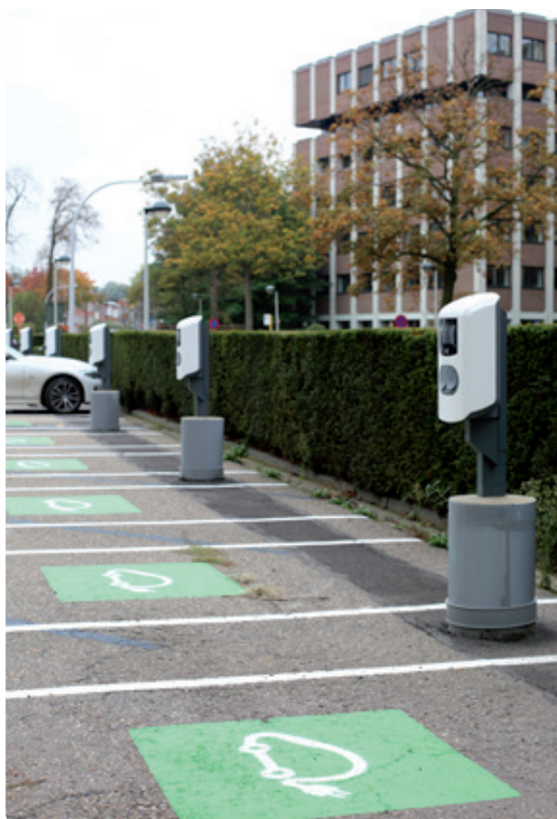
Momenteel staan er op Gevaert 5 16 laadpalen van het type AC voor 32 wagens ter beschikking.
