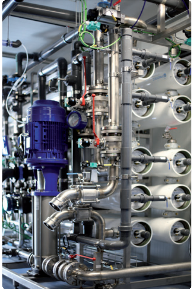
Deze membraanpakken zorgen door middel van omgekeerde osmose voor het nodige ultrapuur en gedemineraliseerd water.
