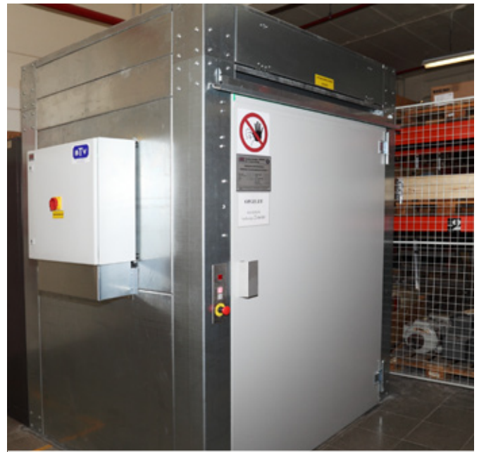
Voor het goederenvervoer werd een nieuwe goederenlift met een laadvermogen van 1.000 kilogram geïnstalleerd.
